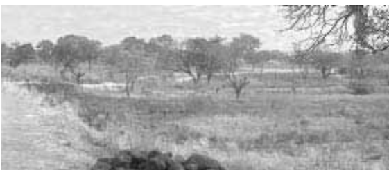
La retenue d'eau après réparation.
