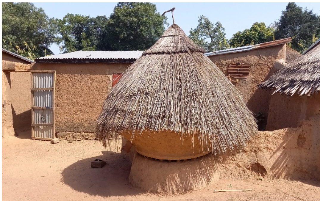
Photo 5: Grenier Traditionnel Amélioré avec une vanne des deux côtés et un couvercle amovible. La vanne facilite l'accès au stock et réduit la nécessité d'ouvrir le grenier, ce qui diminue le risque de contamination du stock.
